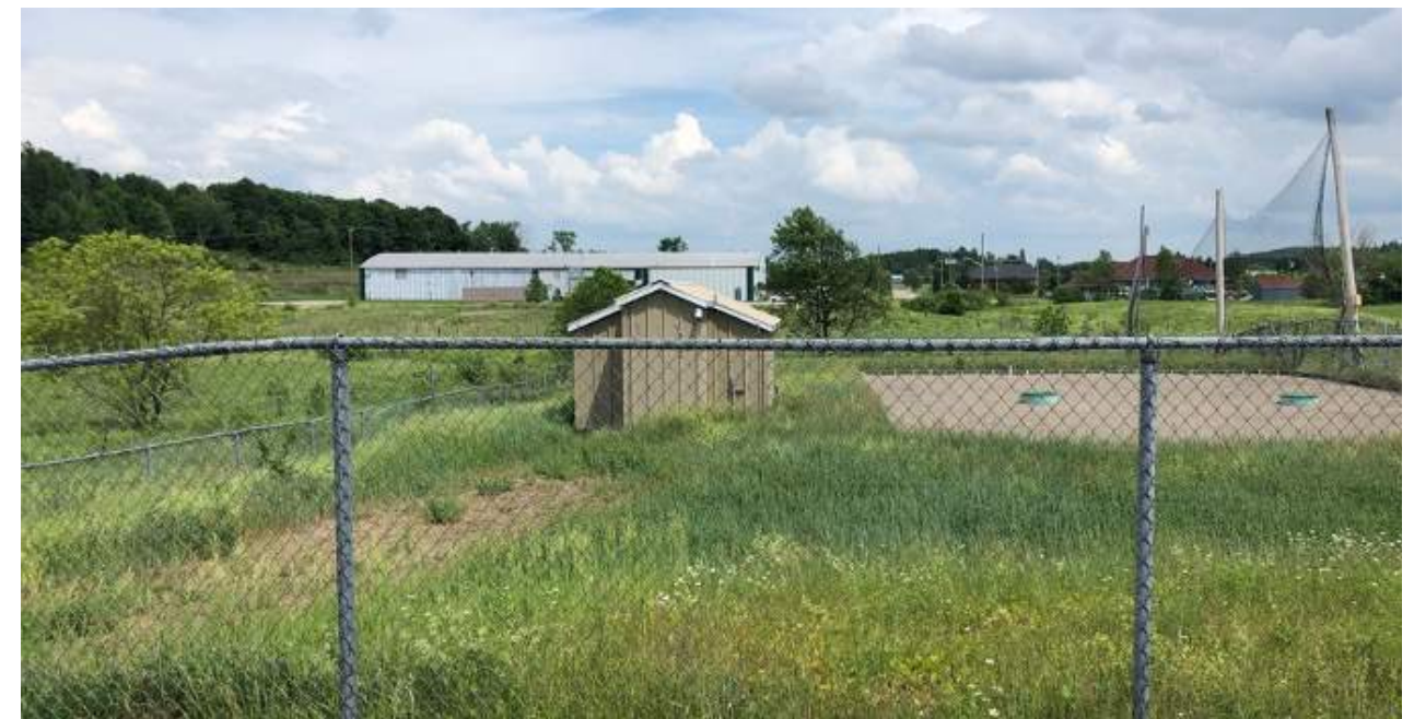
Vue de la station d'épuration des eaux usées au centre du parc
